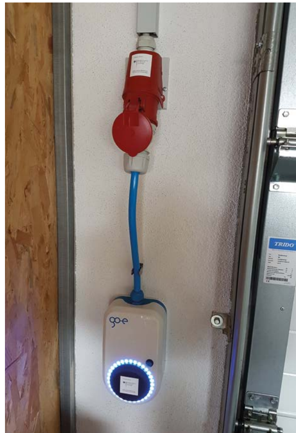
Abbildung 17: Betriebsbereite portable Wallbox in diskreter Wandhalterung
